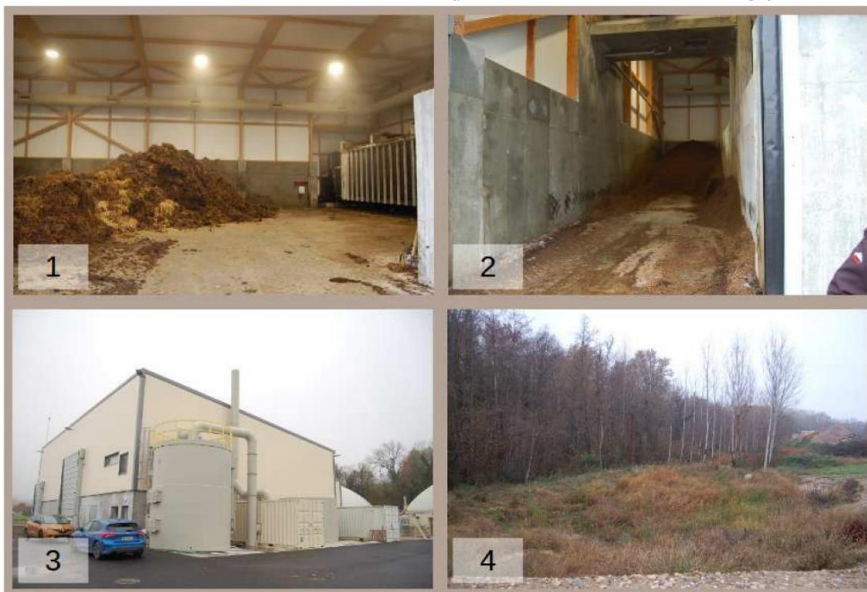
Illustration 3: Cliché 1, zone de préparation des fumiers et lisiers avec la cuve de mélange à droite et la canalisation d'aspiration des odeurs en haut du bardage ; Cliché 2, zone de stockage des digestats solides ; Cliché 3, vue sur le biolaveur et la cheminée ; Cliché 4, zone de lagunage pour les eaux de ruissellement en aval du site.
